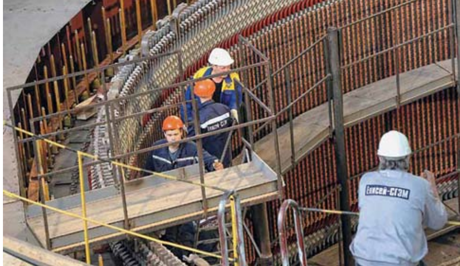
Ремонтные работы на Саяно-Шушенской ГЭС
