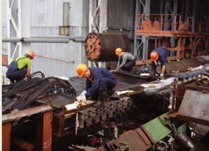
Процесс ремонта конвейерной ленты
