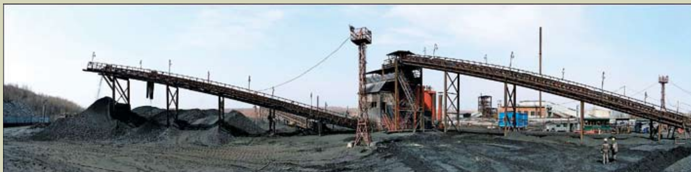
Комплекс сухого пневматического обогащения FGX-12 в ШУ «Восточное»
