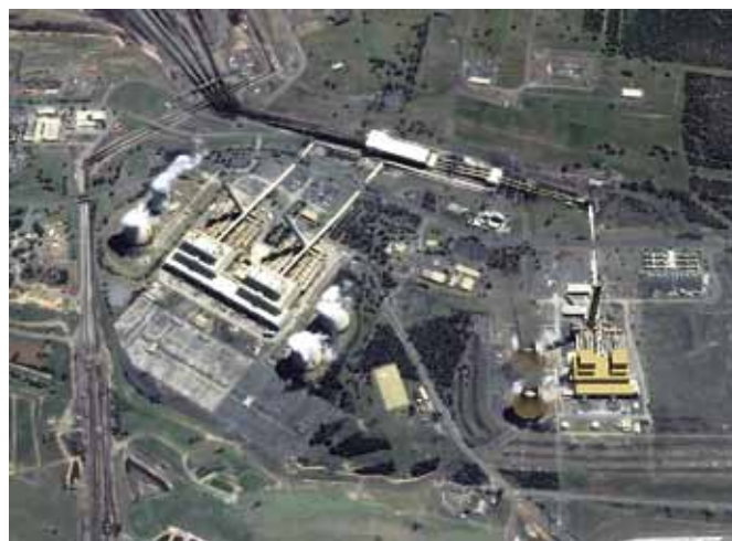
Рис. 3. Промышленные площадки тепловых электростанций, потребляющих уголь с разреза «Тралалгон-Восток» (справа западная очередь станции, слева – восточная)
