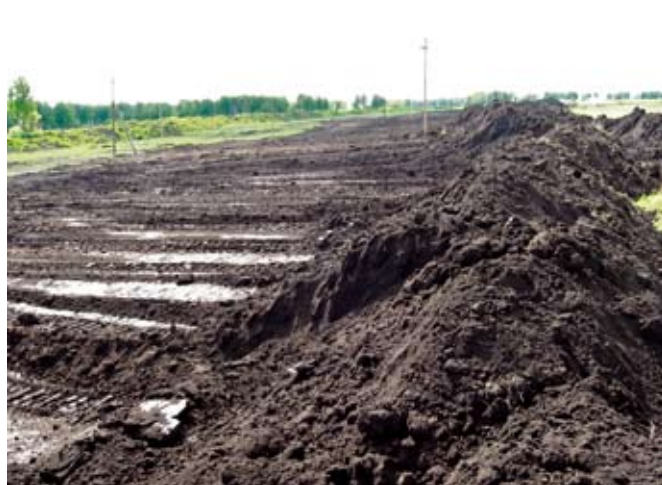
Рис. 1. Снятие плодородного слоя почвы бульдозером на начальном этапе формирования почвенной смеси для рекультивации породных отвалов
