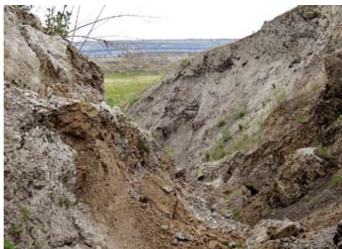
Рис. 2. Техногенный рельеф породных отвалов после рекультивации по ГОСТ: а — овраг в откосе породного отвала; б — фрагмент поверхности отвала без растительности в секторе выноса породы при водной эрозии
