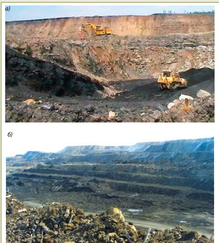
Рис. 2. Выемка угля (а) и сформированные полки для обрушивания блока (б)
