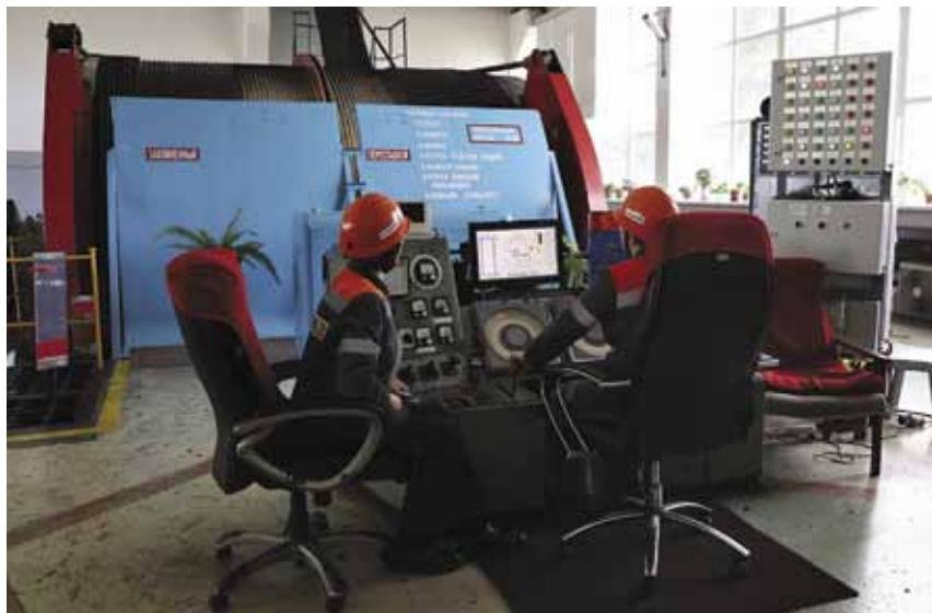
На участке по обслуживанию вентиляторов главного проветривания
