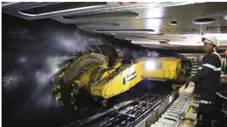
Монтаж оборудования на шахте «Юбилейная»
