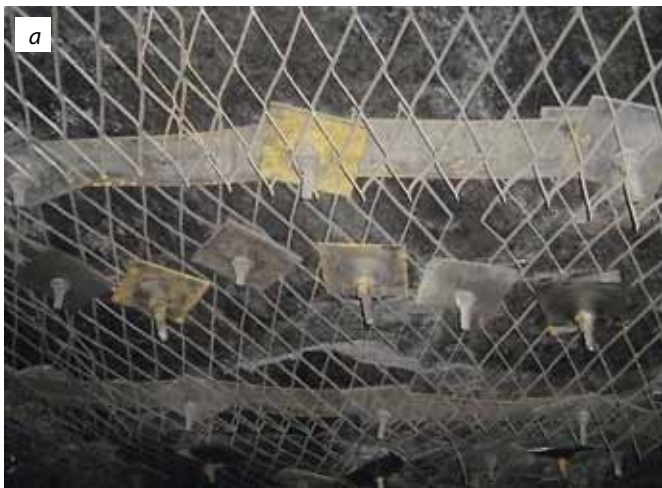
Рис. 2. Технологическая схема усиления крепления сопряжения лавы с конвейерным штреком с использованием канатных анкеров: а, б – соответственно стабильное и нестабильное (с вывалами) состояния сопряжений
