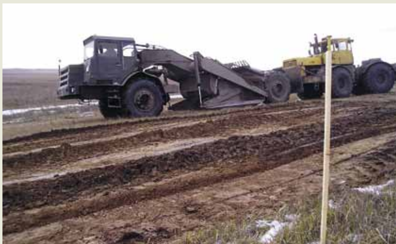
Начало работ на участке № 4 разреза «Изыхский» в 2006 г.
