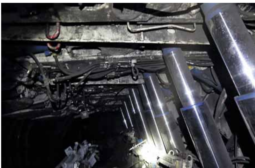
Секции крепи КН15/30 на сопряжении лавы с откаточным штреком в условиях шахты «им. Ленина»
