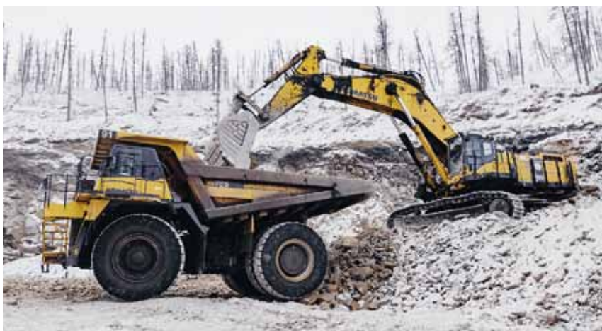
Участок Открытых горных работ
