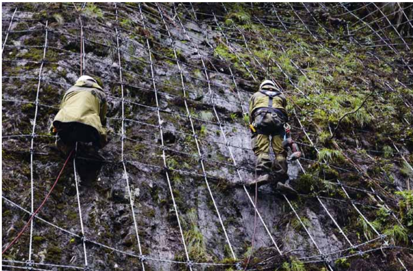
Рис. 1. Закрепление скального массива с использованием канатно-анкерной системы
