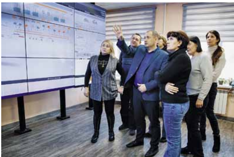
На видеостене центральной диспетчерской предприятия - все параметры работы оборудования
