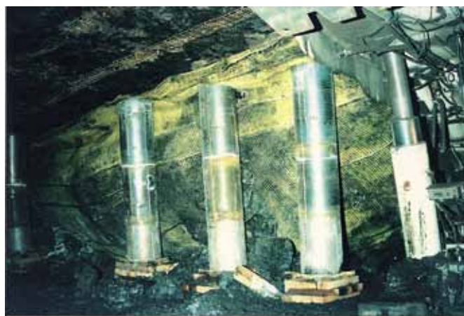
Рис. 6. Применение сетки HUESKER для крепления кровли в демонтажной камере
