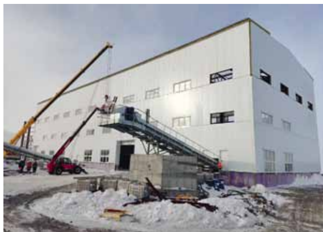
Рис. 2. Строительство обогатительной фабрики
