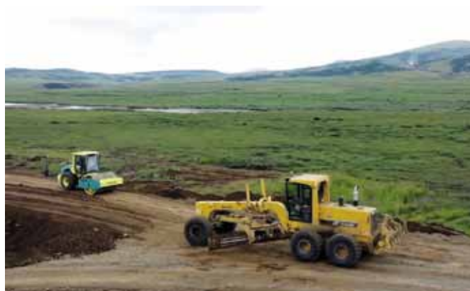
Рис. 1. Строительство дороги от месторождения угля до морского порта «Беринговский»
