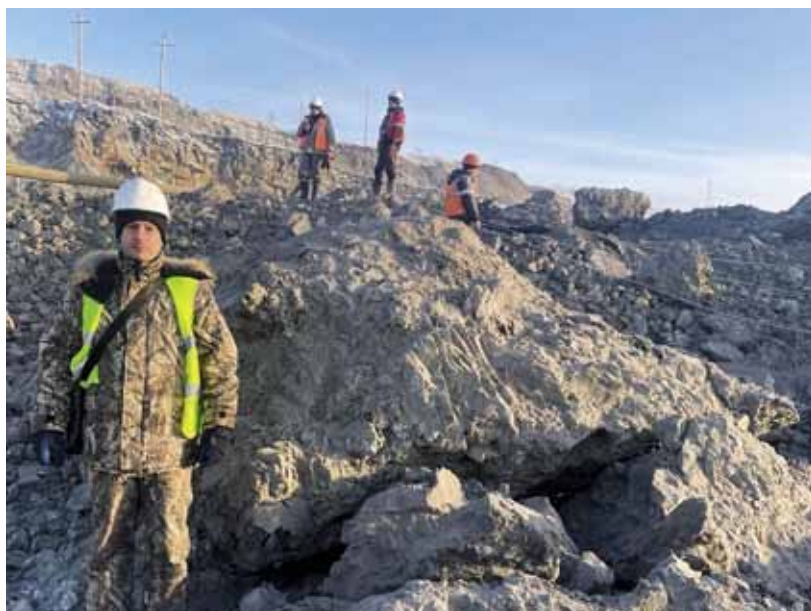
Экспериментальные буровзрывные работы Test drilling and blasting operations
