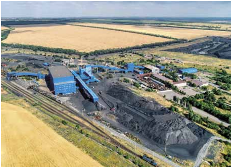
Рис. 1. Общий вид промплощадки Шахтоуправления «Садкинское»
