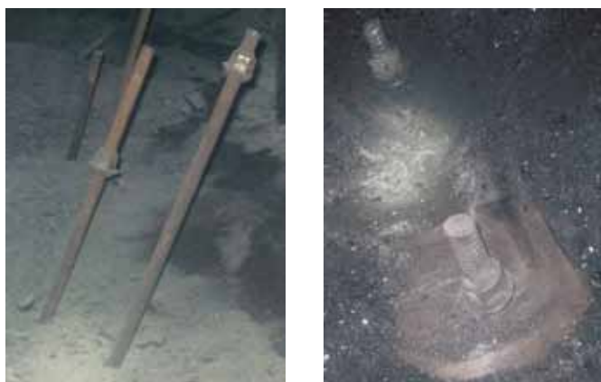
Рис. 4. Установка в почву металлических анкеров вдоль боков в газодренажном штреке № 322Д 7 -з на шахте «Казахстанская»: а – схема крепления; б – разгрузочные анкеры; в – ограждающие анкеры
