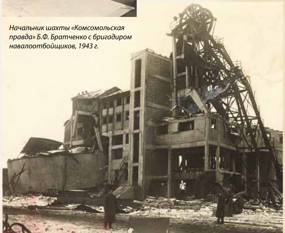
Так выглядели разрушенные фашистскими оккупантами шахты Донбасса, 1943 г.
