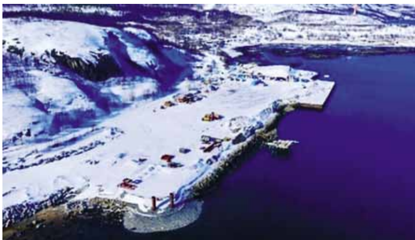
Строительство морского угольного терминала «Лавна» [20]
