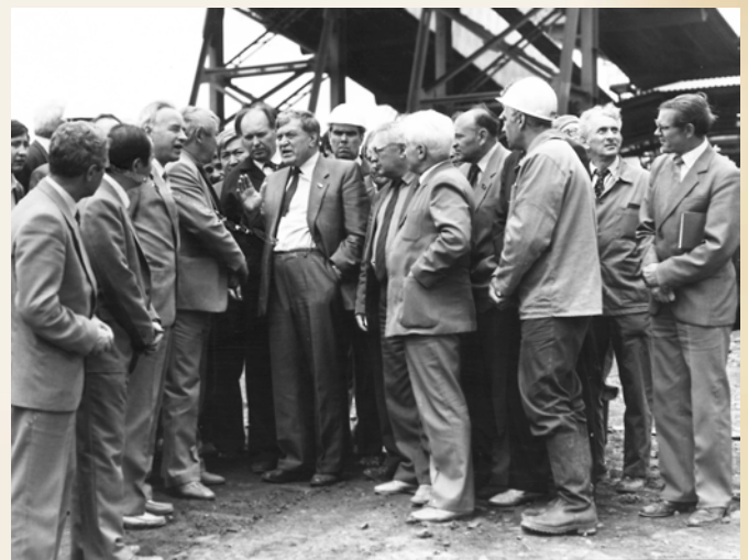
М.И. Щадов на строительстве погрузочного комплекса разреза «Восточный». Экибастуз, 1985 г.
