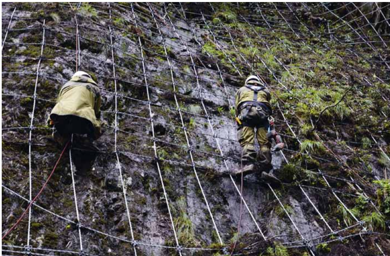
Рис. 1. Закрепление скального массива с использованием канатно-анкерной системы
