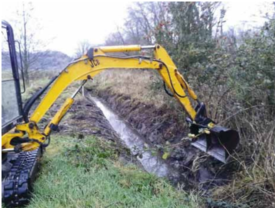
Рис. 4. Строительство нагорной канавы
