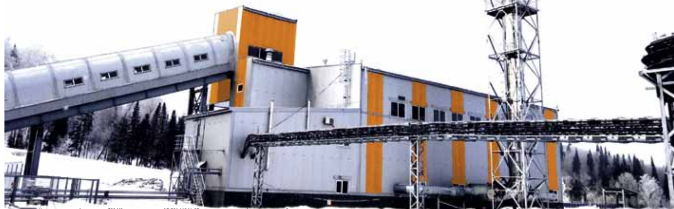
Котельная тепловой мощностью 37,8 МВт с гитовой котловиной КВ 7,56-110 ШИВТ, тепломосильность - антифриз, Кемеровская область
