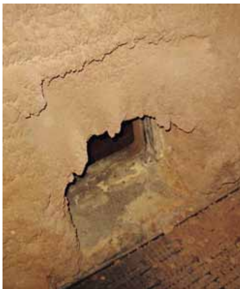
Рис. 2. Стеkanie шлака по стенам топки
