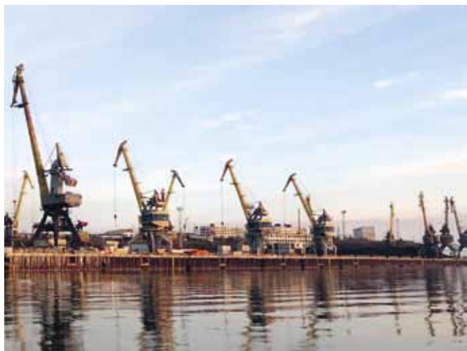
Терминал морского порта «Зеленый Мыс» для перевозки угля, п. Черский. Фото А.Н. Слепцова, август 2021 г.
