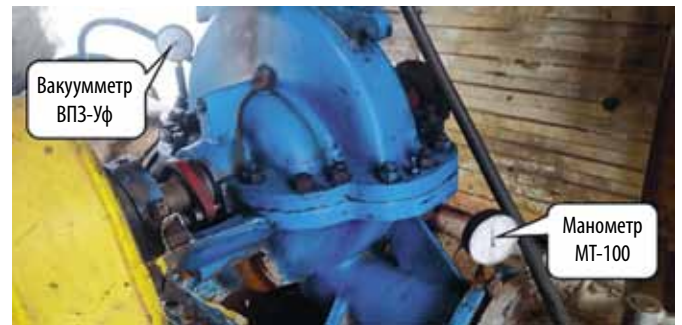
Рис. 2. Насос № 1 марки 1Д630-90
