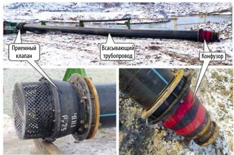
Рис. 5. Всасывающий трубопровод с внутренним диаметром 396,6 мм на монтажной площадке
