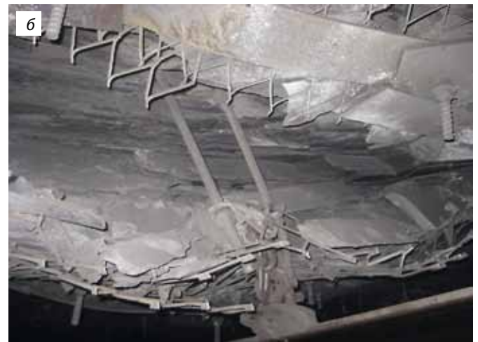
Рис. 2. Технологическая схема усиления крепления сопряжения лавы с конвейерным штреком с использованием канатных анкеров: а, б – соответственно стабильное и нестабильное (с вывалами) состояния сопряжений
