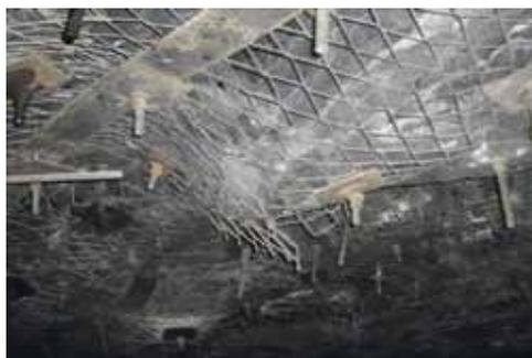
Проявления горного давления в присечных выработках: а – деформации в виде прогибов кровли горной выработки, закрепленной одноуровневой анкерной крепью; б – куполообразование в кровле выработки при комбинированной крепи выработки
