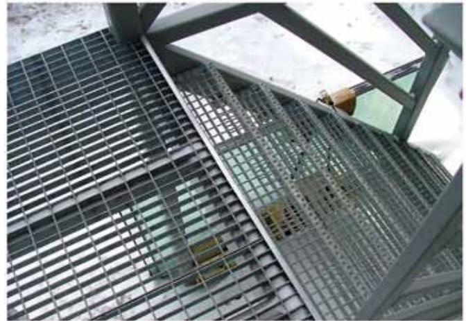
Рис. 3. Замена стандартного покрытия площадок обслуживания на пресс-настил
